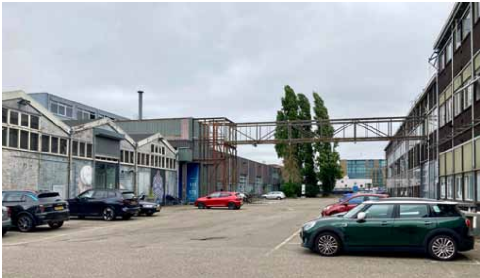
Links de gebouwen die gesloopt worden. De parkeerplekken tussen die gebouwen en de Kromhouthal (rechts) kunnen een tijdje niet gebruikt worden.
